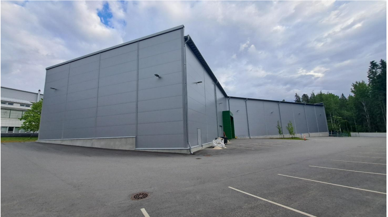
Alueen eteläpuolella sijaitseva liikuntahalli. (kuva Jyväskylän kaupunki, asemakaavoitus 2.6.2026)
