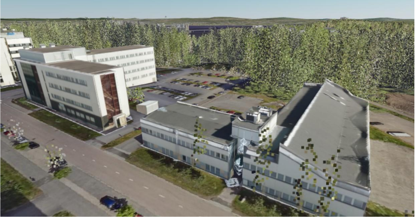
Vasemmalla nykyinen nelikerroksinen toimistorakennus, oikealla matalampi suunnittelualueen rakennus.
